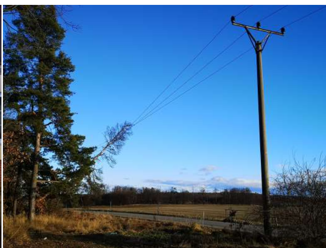
Pomocí motorové řetězové pily jsme odstranili strom u Horních Kounic spadlý na dráty elektrického vedení.
